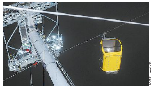
ACCIDENTE. El cable desprendido cuelga entre las torres 26 y 27
