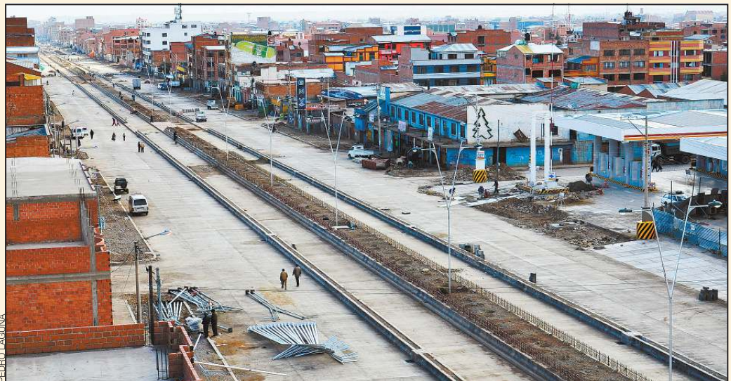
Terminan el asfaltado sólido de la doble vía El Alto-Viacha. Dos carriles, de ida y vuelta, para los buses Sariri son la novedad de la ruta, a la que solo le faltan trabajos complementarios de señalización y pintura. A16
