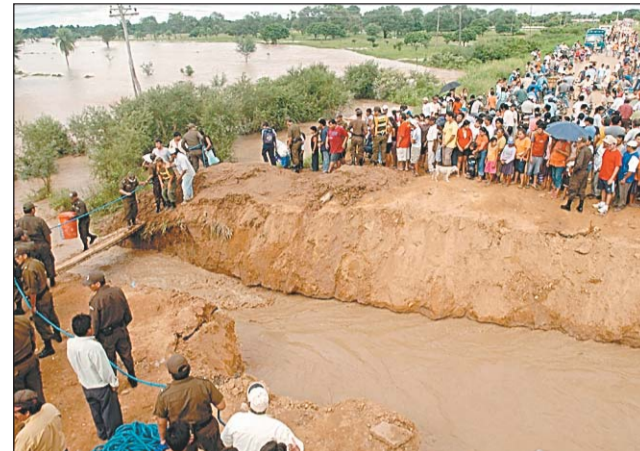
SANTA CRUZ • Cortaron la ruta para desviar el río.
